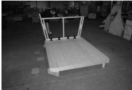
Wenn die Bodenplatte mit dem vorbereiteten Fundament verschraubt ist, können Sie mit der Aufstellung der Rückwand beginnen.
